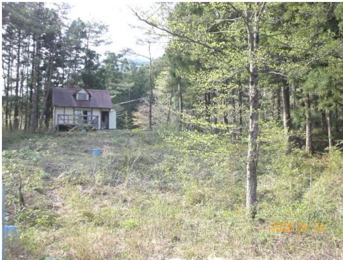
建設予定地内下斜面より撮影
